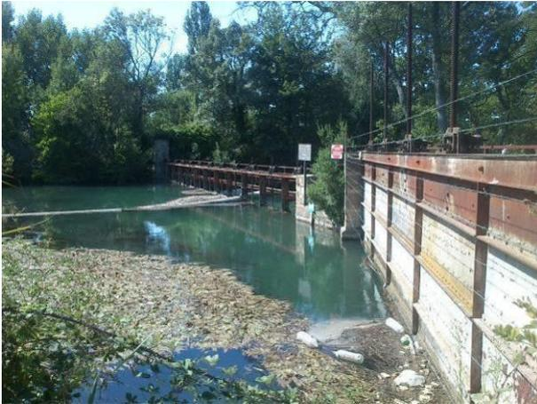
*Photo 99 - Vannes barrage de Valobre (Barrage amont) - Face aval des vannes du barrage (coté gauche de la photo) et vannes d'isolement du canal de prise de la microcentrale (coté droit de la photo)*
