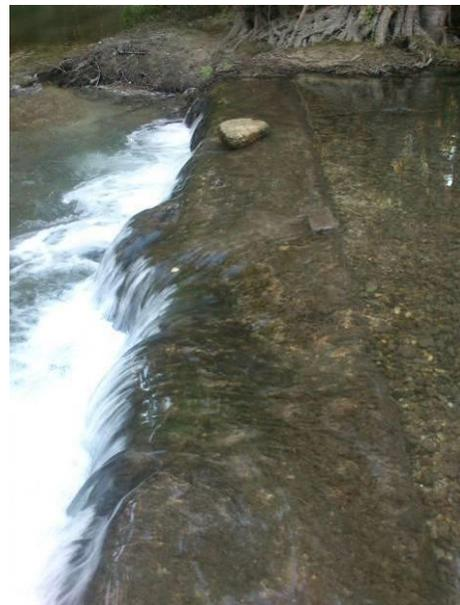
*Photo 107 - Vannes barrage de Valobre (Seuils intermédiaire) - Couronnement du deuxième seuil intermédiaire*
