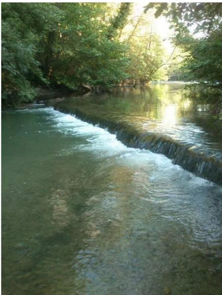
*Photo 106 - Vannes barrage de Valobre (Seuils intermédiaire) - Parement aval et fosse de dissipation du premier seuil intermédiaire*
