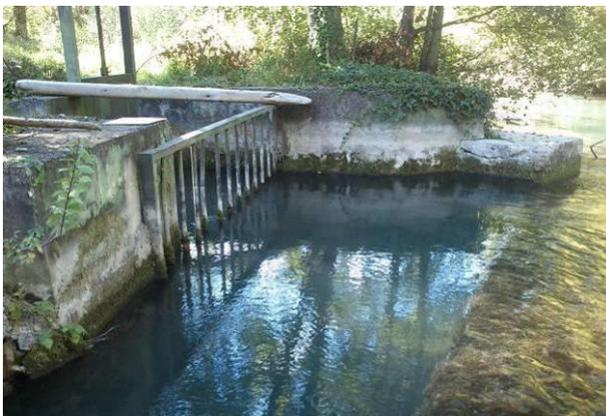
*Photo 139 - Seuil du Moulin de la ville (Aval) - Extrémité amont du bec de canard*
