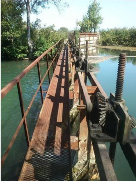
*Photo 105 - Vannes barrage de Valobre (Barrage amont) - Dispositifs de manœuvre des vannes*
