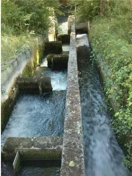
*Photo 144 - Seuil du Moulin de la ville (Aval) - Vue d'ensemble de la passe à poissons existante*
