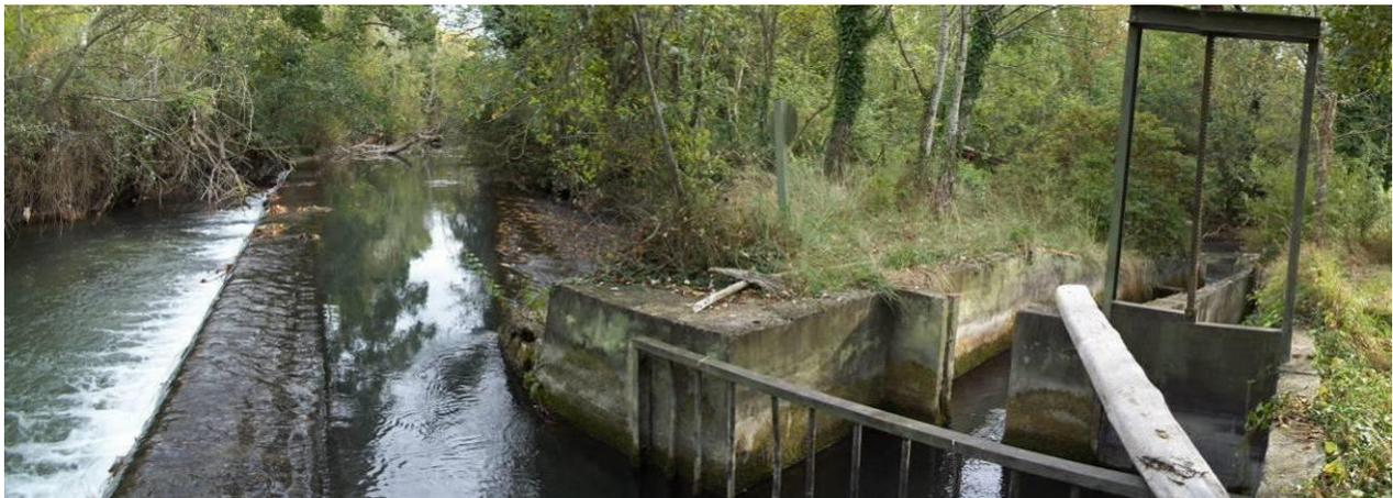
Photo 121 - Seuil du Moulin de la ville (Aval) - Vue d'ensemble du seuil et de l'entrée hydraulique de la passe à poissons
