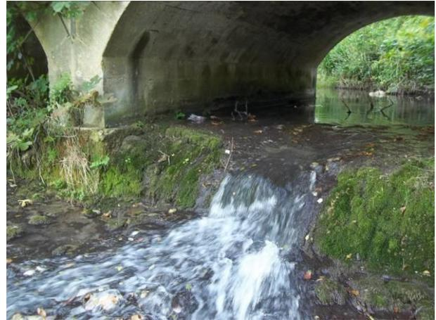
*Photo 152 - Seuil du Pont de l'Avocat - Radier de protection en limite aval du pont de la RD146*
