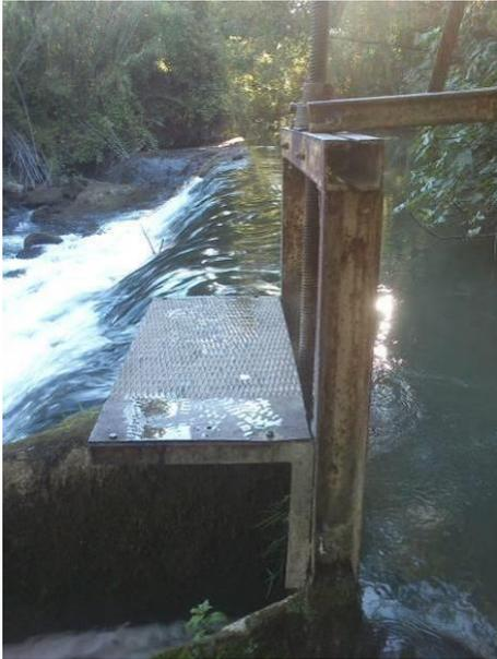
*Photo 91 - Seuil de la patience - Cadre et dispositif de manœuvre de la vanne de décharge*
