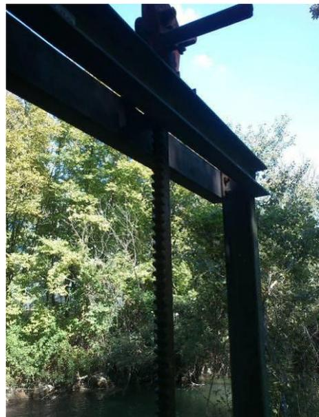
*Photo 147 - Seuil du Moulin de la ville (Aval) - Dispositif de manœuvre de la vanne de régulation du débit d'attrait de la passe à poissons*
