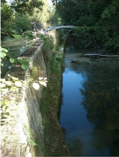
*Photo 122 - Seuil du Moulin de la ville (Amont) - Parement aval vertical*
