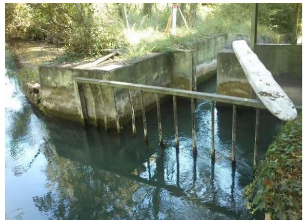
*Photo 143 - Seuil du Moulin de la ville (Aval) - Prise d'eau de la passe à poissons*
