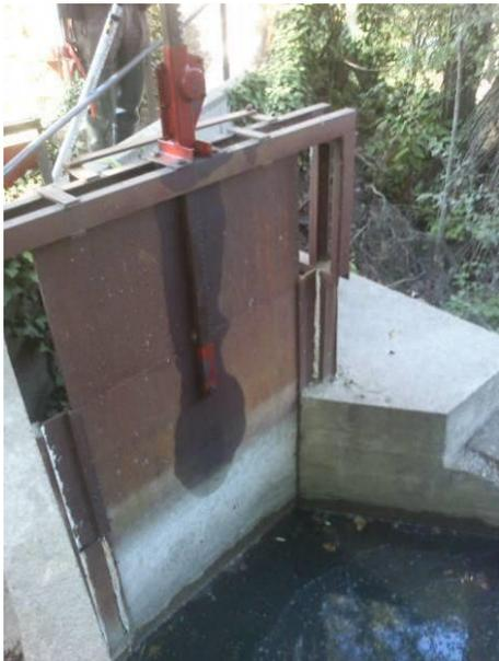
*Photo 119 - Vannes barrage de Valobre (Seuil aval)
