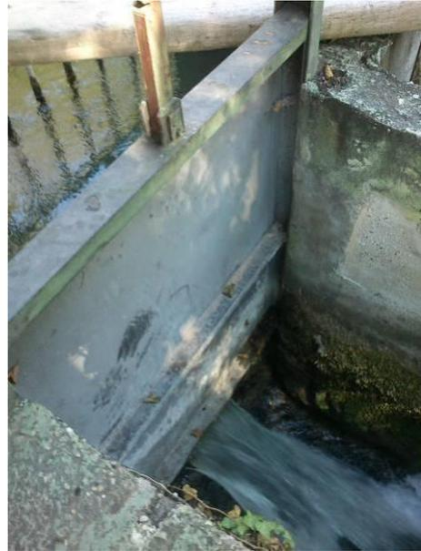
*Photo 145 - Seuil du Moulin de la ville (Aval) - Vanne de régulation du débit d'attrait de la passe à poissons*
