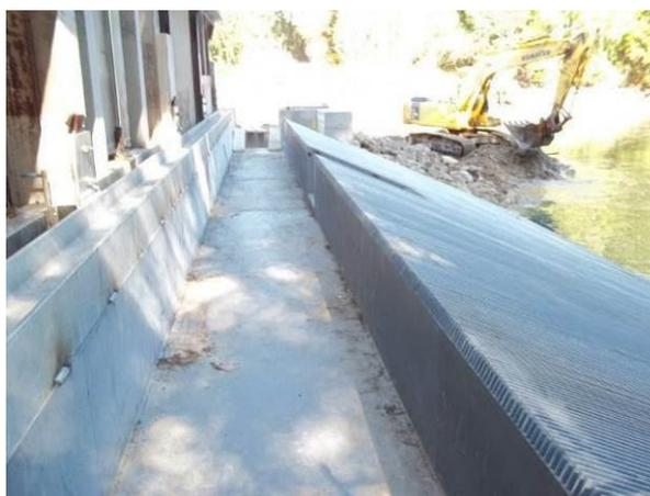
Figure 41 : Exemple d'un canal de dévalaison métal avec son déversoir de dévalaison en rive droite (Carabotte, Hérault)
