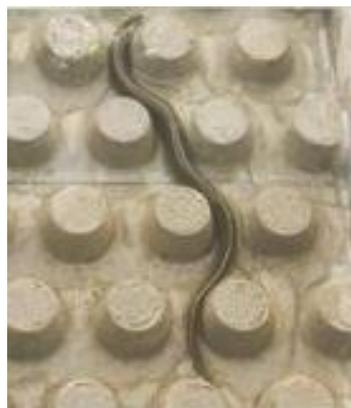
La rampe à dalle evergreen est alimentée, le plus souvent via une échancrure en crête de l'ouvrage, par de faibles débits assurant une lame d'eau de 1 à 3 mm sur sa déclivité. La rampe, en léger dévers latéral, offre aux anguilles différentes conditions d'écoulements, de tirant d'eau, de vitesse et d'humidité. La principale limite de cette solution est donc aussi liée aux fluctuations du niveau d'eau amont.
