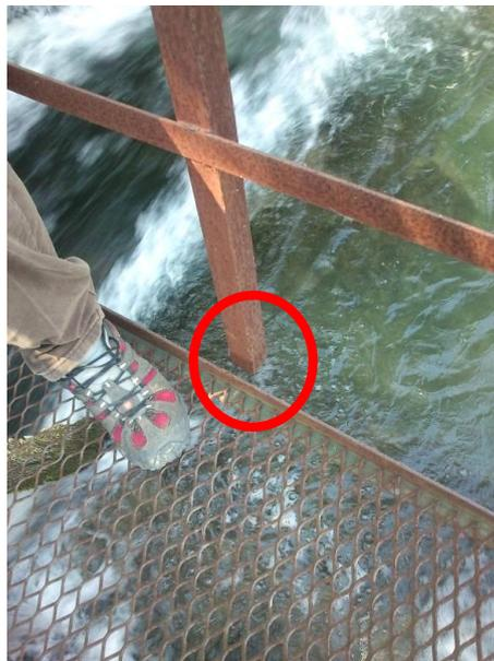
**Moulin de Valobre** : corrosion importante des garde-corps de la passerelle du barrage + passerelle non conforme aux réglementations de sécurité
