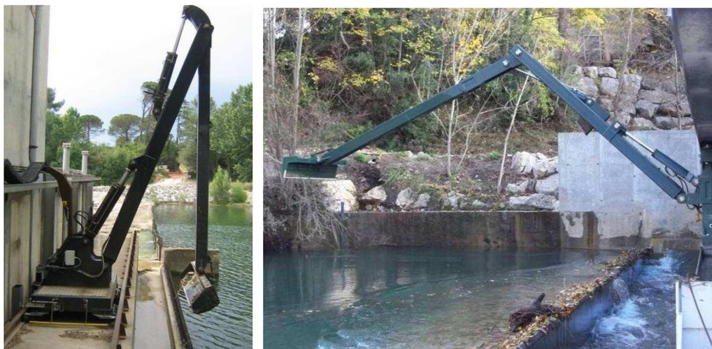
Figure 39 : Vue d'un dégrilleur racloir sur rails (Carabotte, Hérault)
