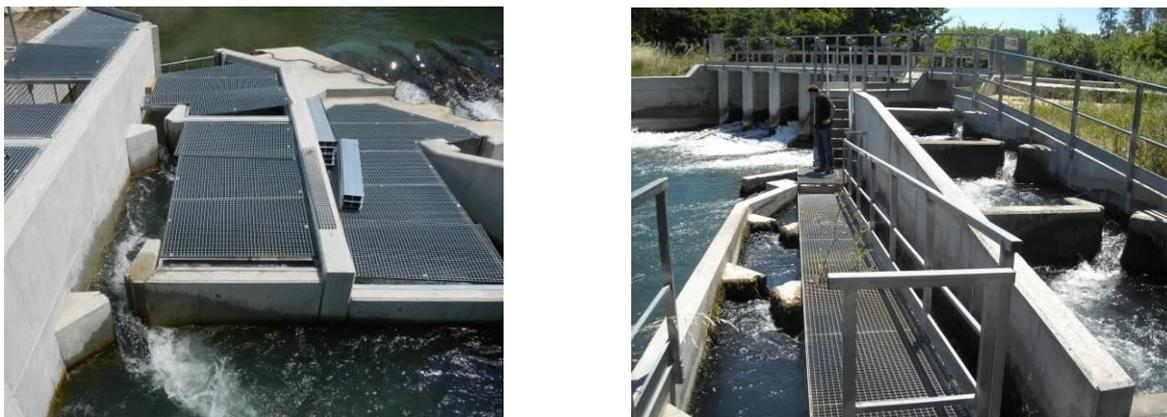
**Figure 31** : Passe à fentes verticales profondes de la prise d'eau de Beaulieu et des 7 Espassiers
