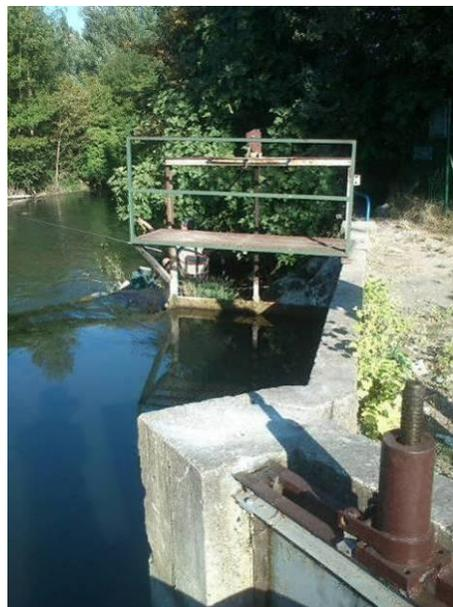
**Moulin vieux** : début de corrosion de la passerelle d'accès rive droite
