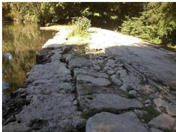
**Croupière** : disparition d'une partie des maçonneries du couronnement du seuil en partie amont rive droite
