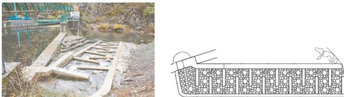
Figure 29 : Rampe en lacet à rugosité (enrochements) Les Sallèles - Vallée du Lot
