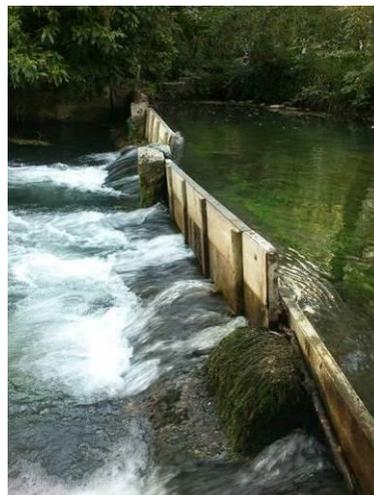
**Réal de Monclar (seuil coté droit)** : mouvement possible (à confirmer sous niveau d'eau plus faible) d'une partie des maçonneries d'appui des batardeaux de régulation en lien avec une fosse aval + usure superficielles des maçonneries
