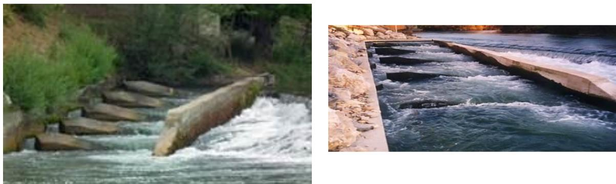
**Figure 34** : Passe à seuils déversants et fentes verticales - Bédarrides
