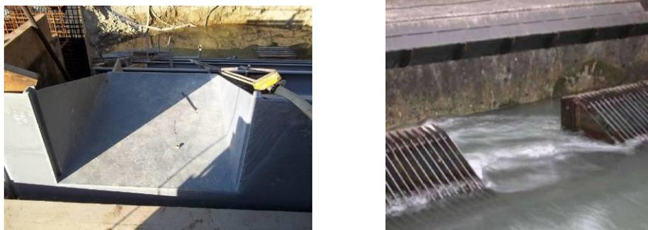
Figure 40 : Déversoir de dévalaison à sec et en fonctionnement (Carabotte, Hérault)
