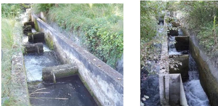
**Figure 32** : Passe à fentes à échancrures latérales du Moulin de la Ville
