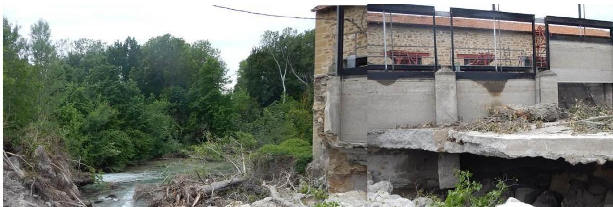
**Figure 42** : Installation endommagée du Moulin de la Ville et érosion régressive du canal consécutive à la rupture de l'ouvrage aval de prise d'eau
