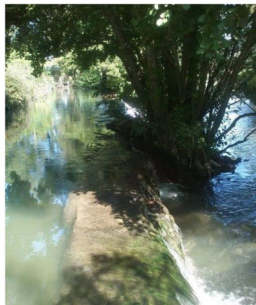
**Moulin des toiles (aval)** : Développement d'un arbre contre le parement aval du seuil : accumulation progressive d'embâcles
