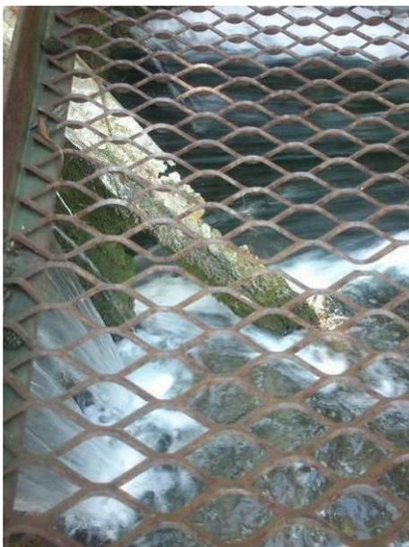
**Moulin de Valobre** : forte corrosion d'une partie des cornières assurant la stabilité des vannes
