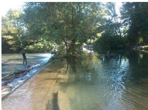
**Moulin vieux** : Développement d'un arbre contre le parement amont du seuil : accumulation progressive d'embâcles
