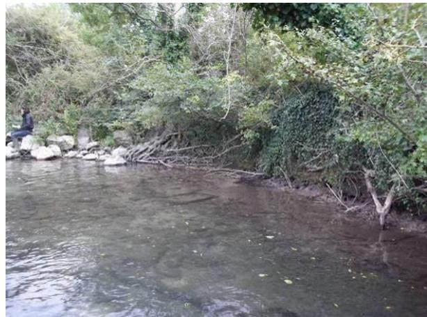
**St Joseph** : forte érosion de la berge aval rive droite ainsi que dans une moindre mesure en rive gauche (en face du seuil) en lien avec la fosse de dissipation formée en aval des vannes de décharge
