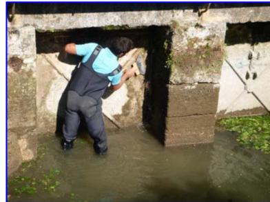
Nettoyage et graissage
