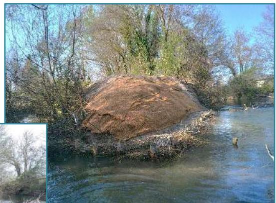
Les travaux sont terminés. Le géotextile biodégradable assure la cohésion de la berge et la protection des branches le temps de la reprise de la végétation, notamment du système racinaire.
