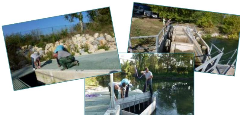
Mise à sec et contrôles sur la passe à poissons de la Croupière
